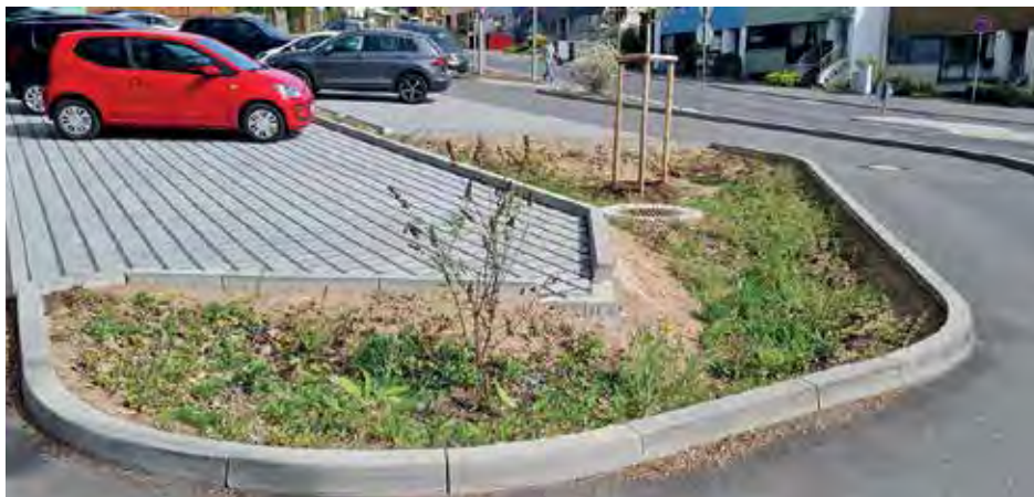
Das Gefälle des Parkplatzes an der Albrecht-Dürer-Straße Ecke Waldstraße wurde so genutzt, dass abfließendes Wasser in einer der drei Versickerungsmulden fließt und damit dem Grundwasser zugeführt wird. Erst wenn die Mulden volllaufen, wird das Wasser in die Kanalisation abgeleitet. Fotos Oliver Wallach
