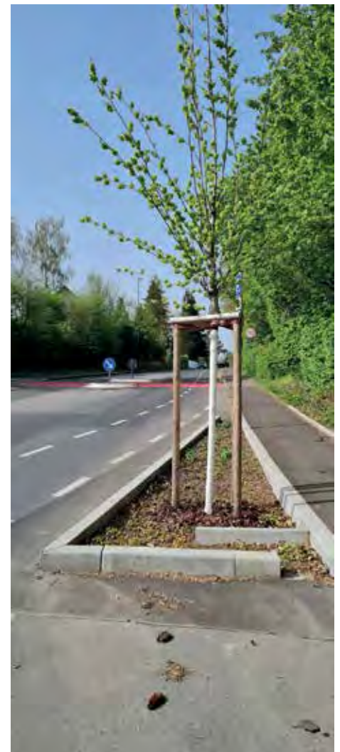
Eine von drei versickerungsfreundlichen Baumscheiben in der Fasanenstraße.
