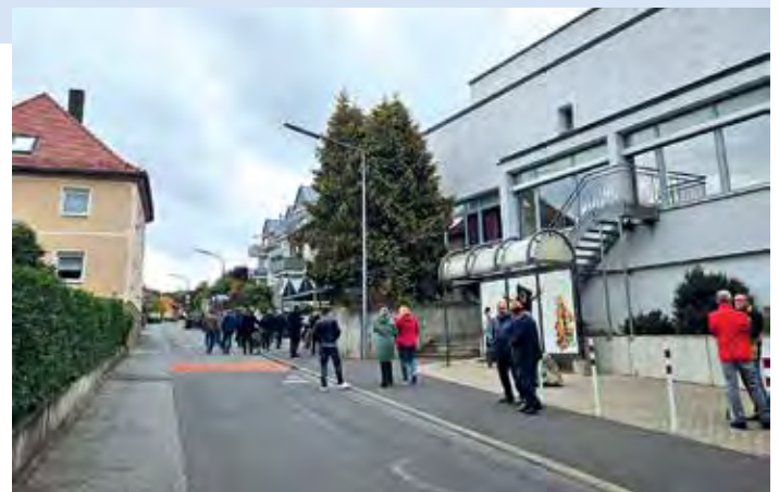
Großprojekt Martin-Wilhelm-Straße: hier gilt es viele Herausforderungen für die anstehende Sanierung zu meistern.
