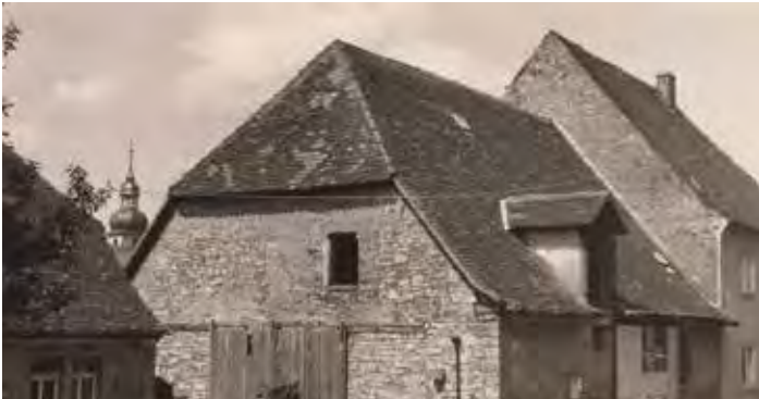
Die ehemalige Schafscheune beherbergte die Gemeindebullen
